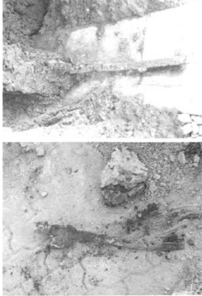
图 2 镀锌扁钢接地开挖图
